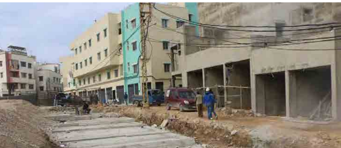
Construcción en el campamento de Nahr el-Bared, Líbano © 2020 UNRWA Foto
