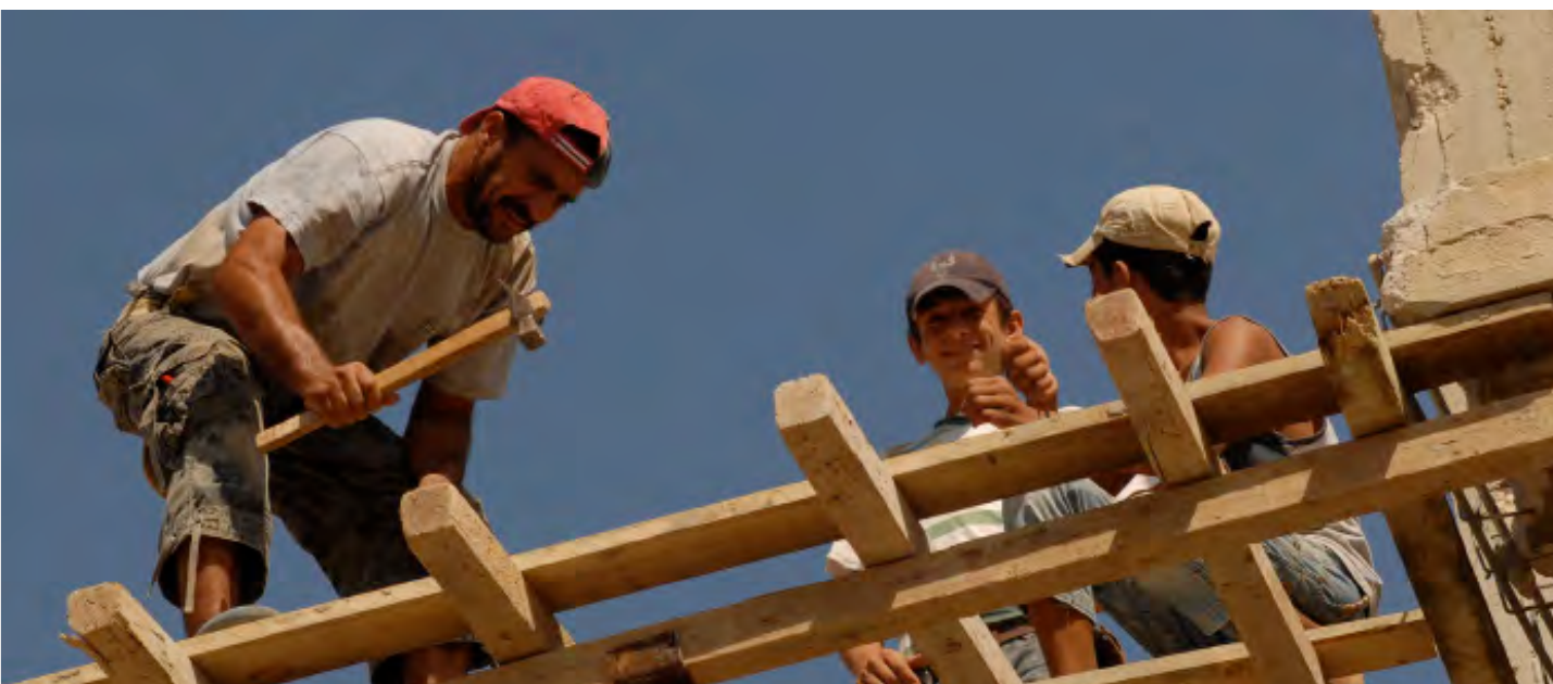
Construcción en Líbano © 2010 UNRWA Foto
